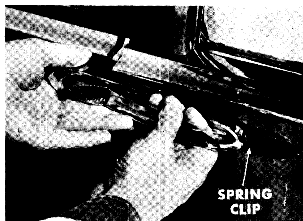
Fig. 35—Removing Door Handle
